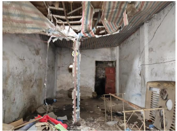
原库房机油储存间（废弃）
