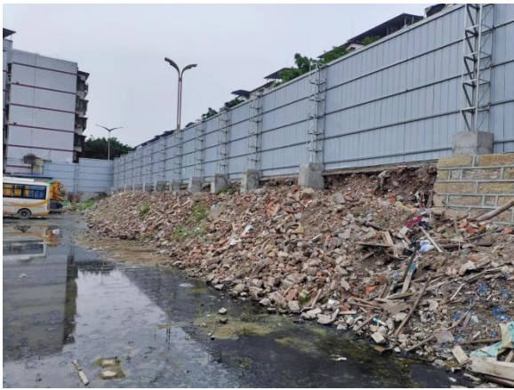
原汽配零售铺面拆除区域
