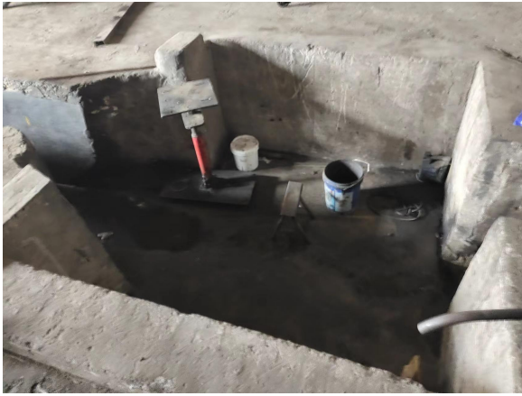
地下检修沟（维修保养区）
