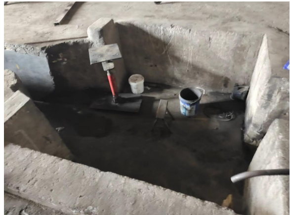
维修保养区 (检修沟)
