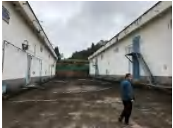
地块西侧现状（照片编号 4#，拍摄方向：西）
