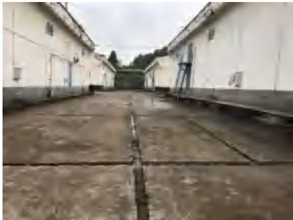
厂区内雨水沟渠
