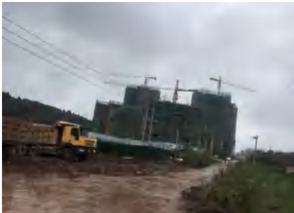
西南侧在建工地（南岳府）
