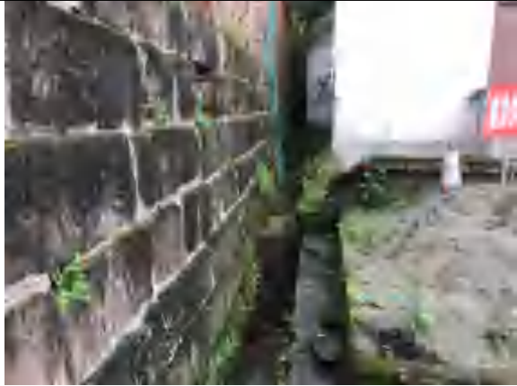
雨水沟渠（连接消防池）
