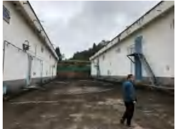
地块西侧现状（照片编号 4#，拍摄方向：西）
