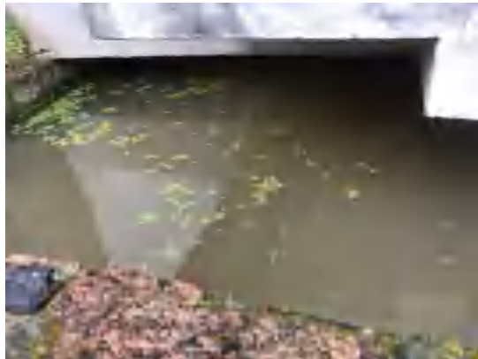
原化验室下消防池（照片编号 5#，拍摄方向：西北）
