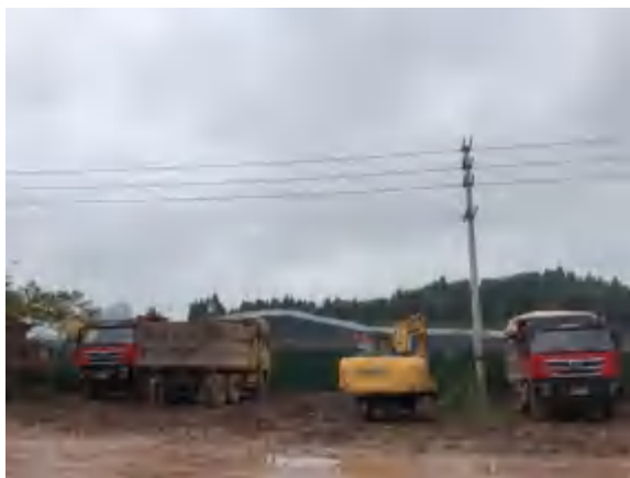
南侧外环境（待建项目）
