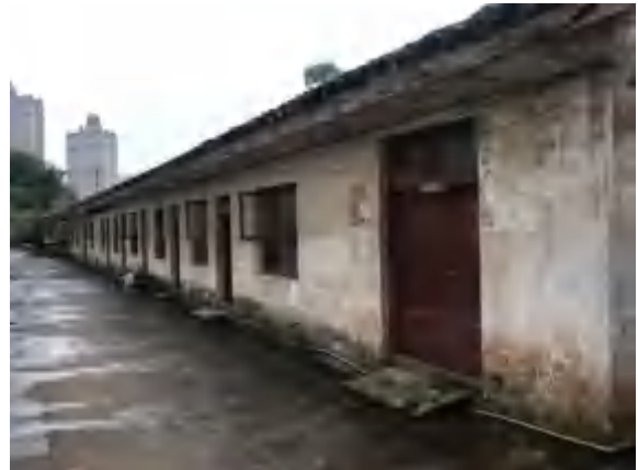
地块南侧现状（照片编号 2#，拍摄方向：东南）
