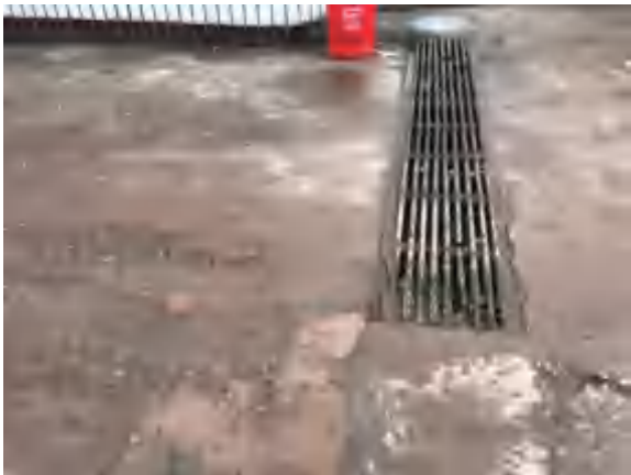
厂区内雨水沟渠
