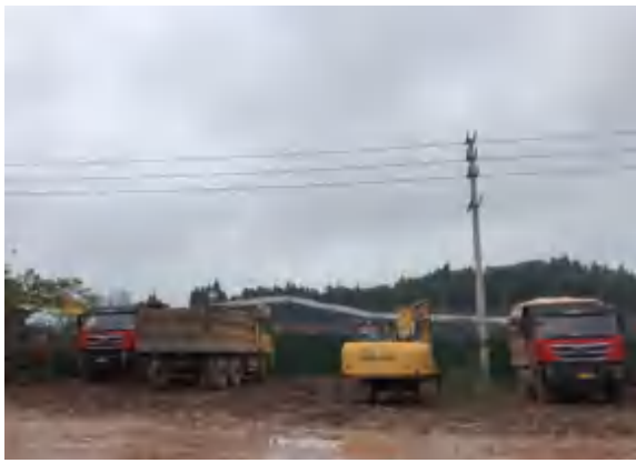
南侧外环境（待建项目）
